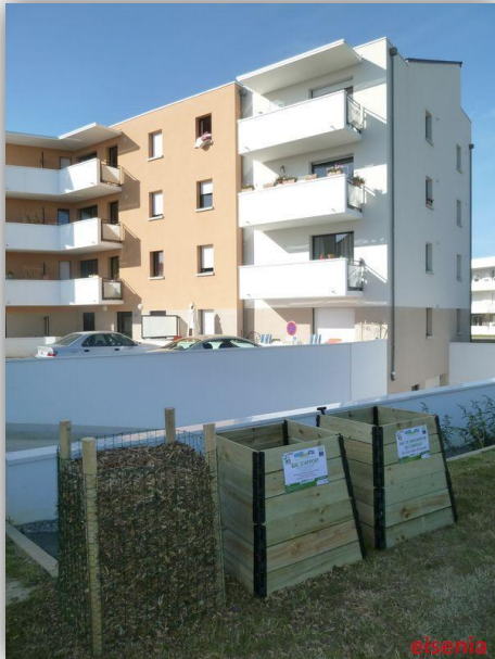
Composteurs collectifs à Rennes
